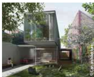
Maison à Asnières (92). Lan architecture, architectes
